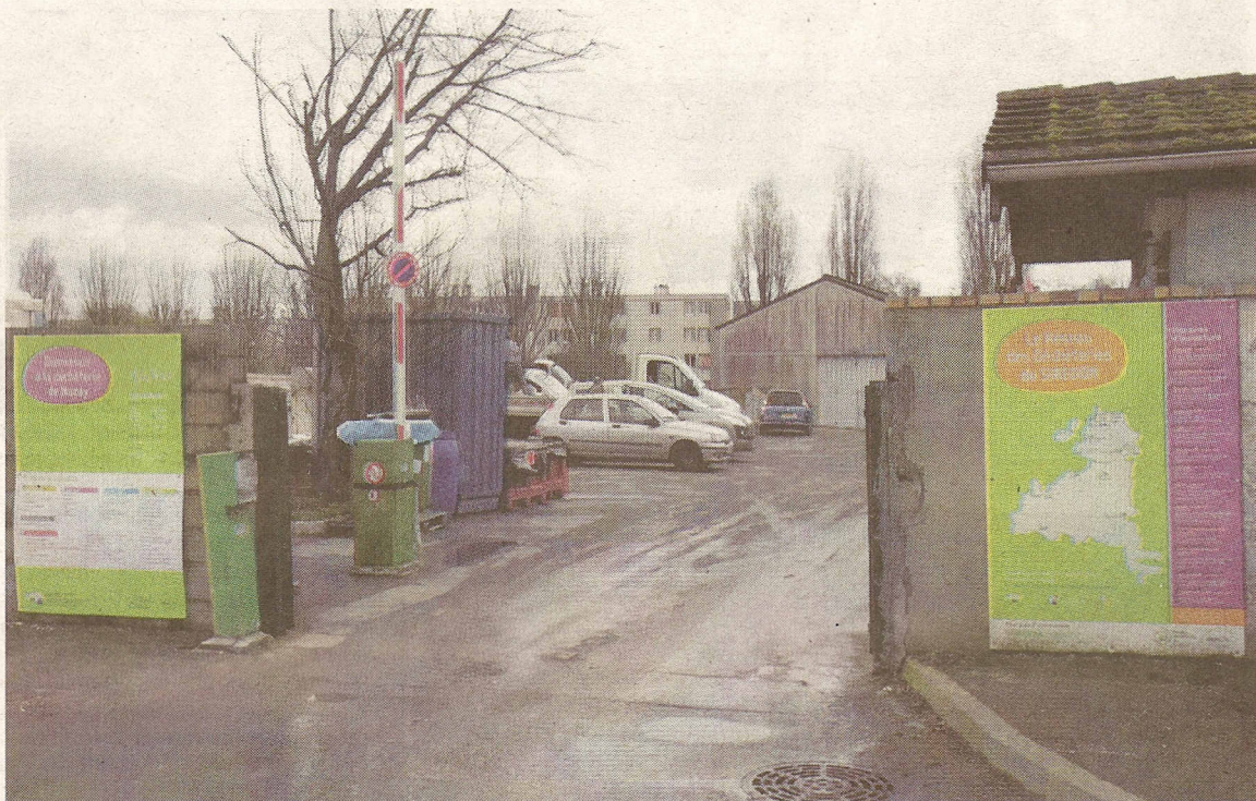
NOZAY, SAMEDI 26 FÉVRIER. La déchetterie de Nozay constitue le point de crispation dans le conflit entre le Sirm et le Siredom. Elle sera entièrement refaite d'ici à septembre.
